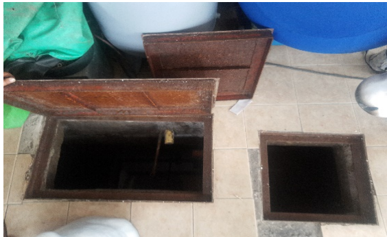
Fotografía 3. Apertura de tanques que comunican con el pozo pz-12-0026
