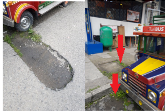
Fotografía 10. Instalación de la tubería de desagüe hacia la red de la principal de la EAB.
